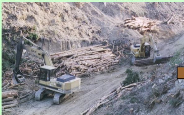
伐採工事で発生する森林資源
