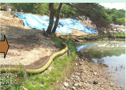
地形に合わせた施工
